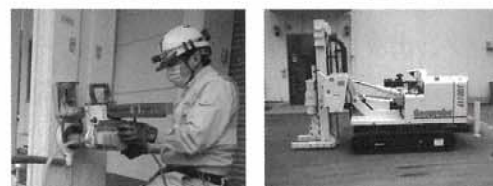
コンクリートコア採取状況
